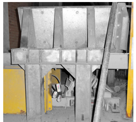
Mehrere 125 ml simalube Schmierstoffspender schmierden den Vibrationsförderer.
