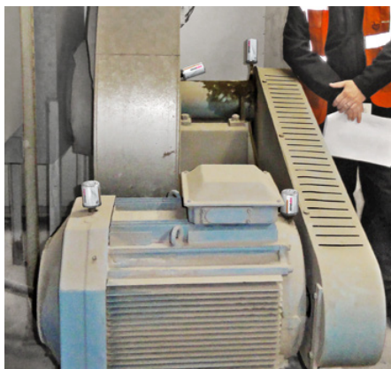
Ein Verbrennungsgebläse – geschmiert mit je zwei 60 ml und 125 ml simalube Schmierstoffspendern.
